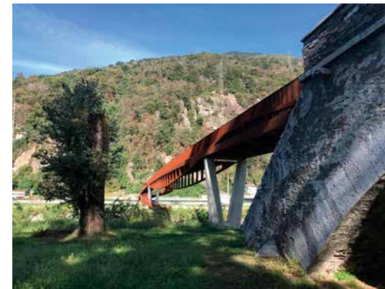
❖ La passerella ciclopedonale del ponte della Torretta. Der Rad- und Fussgängersteg der Turmbrücke Torretta.
