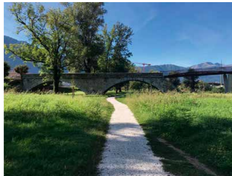
❖ La passerella ciclopedonale d'acciaio innestata su quel che resta dell'ottocentesco ponte della Torretta. Der Rad- und Fussgängersteg aus Stahl, der auf den Überresten der Turmbrücke Torretta aus dem 19. Jahrhundert angelegt wurde.
